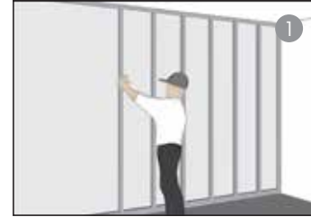
1. ติดตั้งโครง Galvanized Steel C-Stud ให้ได้ตามมาตรฐาน เข็มนาฬิกาและระดับให้ถูกต้อง
