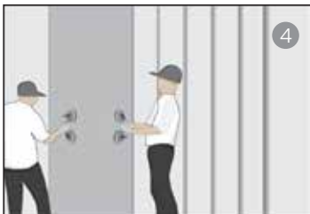
4. ยกแผ่นขึ้นติดตั้งโดยการใช้เครื่องดูด ยกขึ้นในแนวตั้ง ประทับแผ่นกับโครงเหล็กกดให้แน่น เช็กระดับและแนวฉาก ให้ได้ดังทำวิธีการเดินต่อไปเรื่อยๆ เช็ครอยต่อระหว่างแผ่นให้ได้ระดับและแนบสนิท
