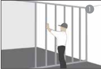
1. ติดตั้งโครง C-Stud ให้ได้ตามมาตรฐาน เช็กระนาบและระดับให้ถูกต้อง
